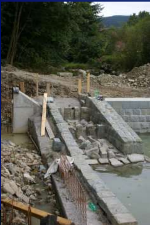
U vyšších stupňů jsou k zajištění průchodnosti vodními živočichy vybudovány migrační rampy s šířkou 2,5 m
