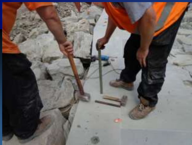
ukládání obkladu přelivné hrany, vrtání, kotvení pomocí sklolaminátových kotevních tyčí, kamenná zátka
