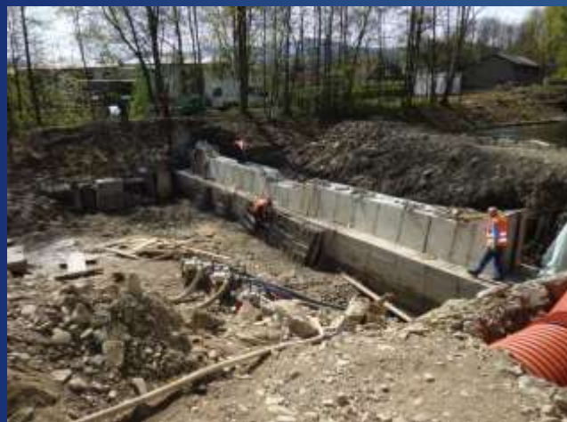
betonáž přelivné hrany
