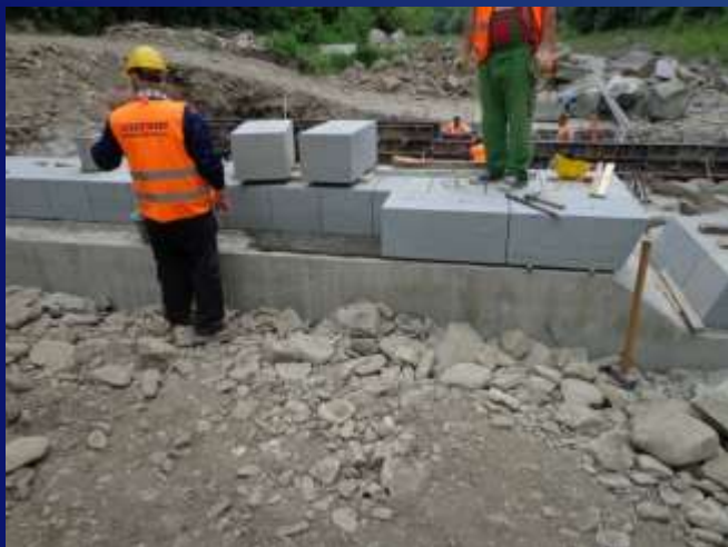
ukládání obkladu přelivné hrany, vrtání, kotvení pomocí sklolaminátových kotevních tyčí, kamenná zátka
