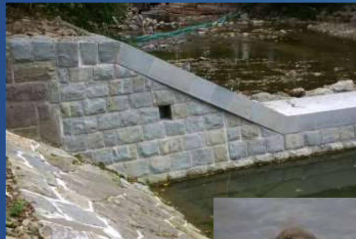
V tělese stupňů jsou zřízeny úkryty pro zpěvného ptáka skorce vodního .
