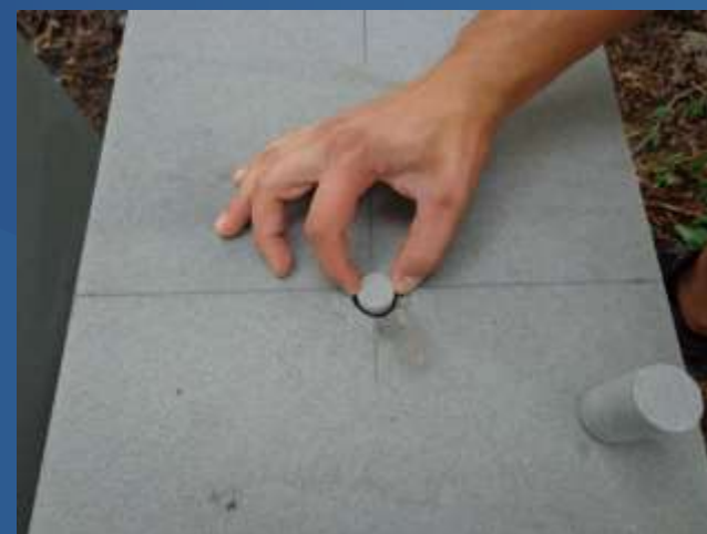
ukládání obkladu přelivné hrany, vrtání, kotvení pomocí sklolaminátových kotevních tyčí, kamenná zátka
