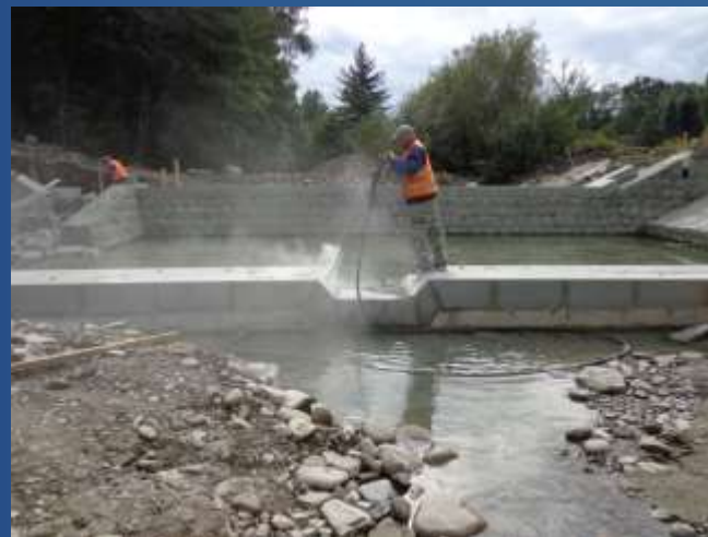
ukládání obkladu přelivné hrany, vrtání, kotvení pomocí sklolaminátových kotevních tyčí, kamenná zátka
