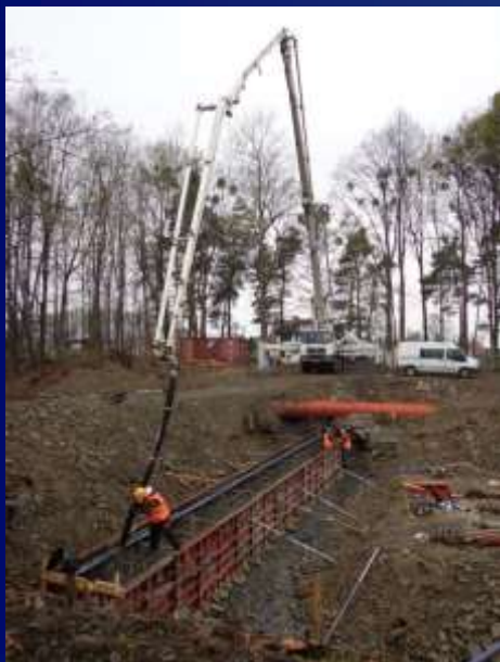
betonáž přelivné hrany
