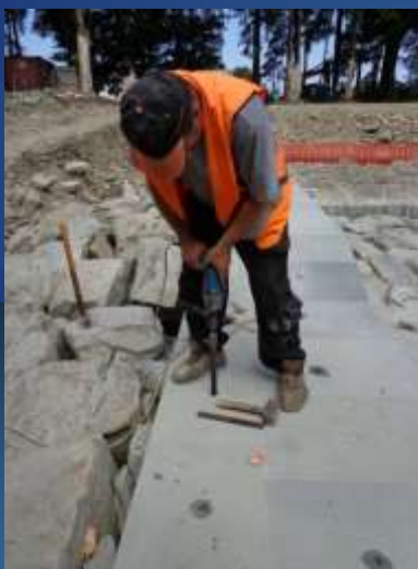
ukládání obkladu přelivné hrany, vrtání, kotvení pomocí sklolaminátových kotevních tyčí, kamenná zátka
