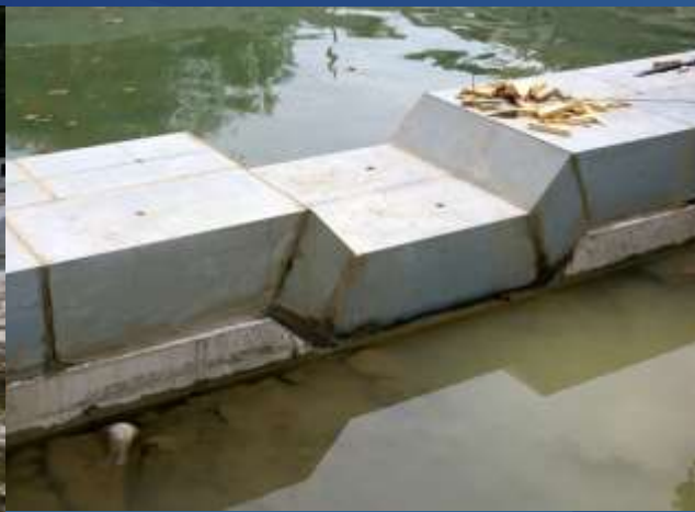
detail kynety umožňující soustředěný odtok z vývaru stupně
