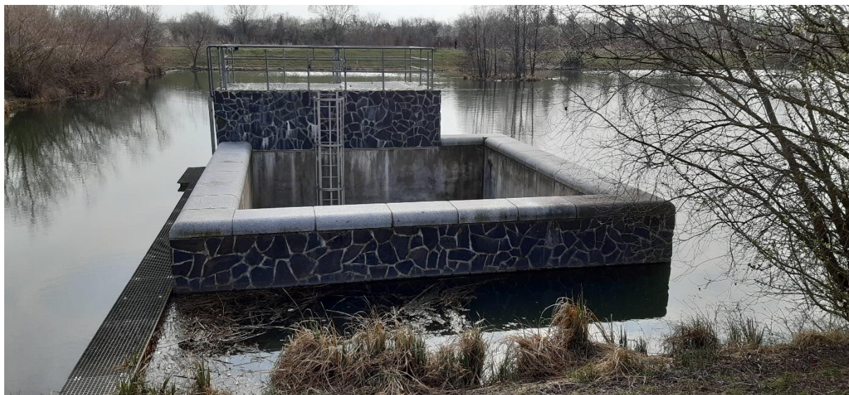
Obrázek 17 – Bezpečnostní přeliv retenční nádrže Říčanka
