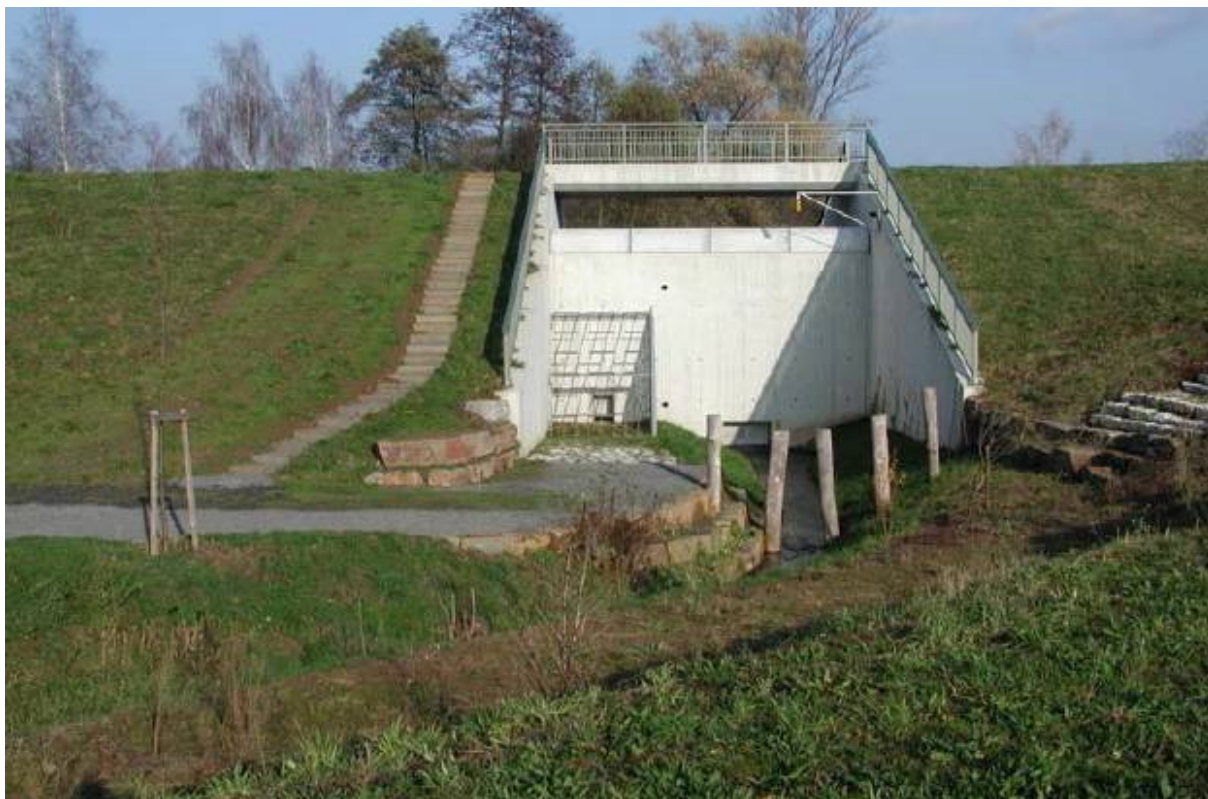
Obr. 4 - Retenční suchá nádrž – protipovodňová ochrana města Hambach, Aubach (ilustrační foto)
