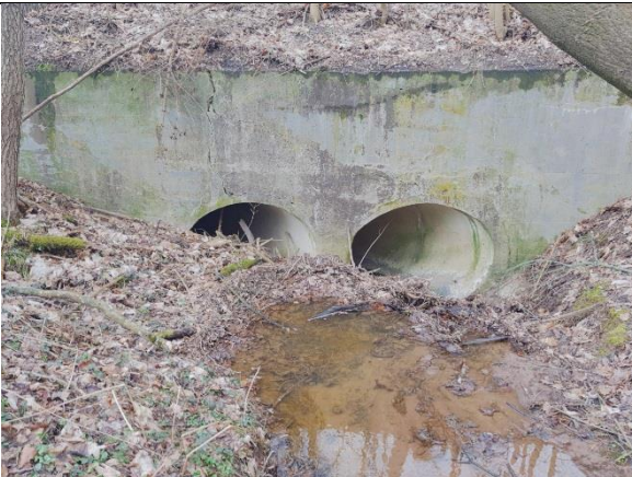
obr. 3 - Částečně zanesený propustek na Bušinci přes silnici II/113
