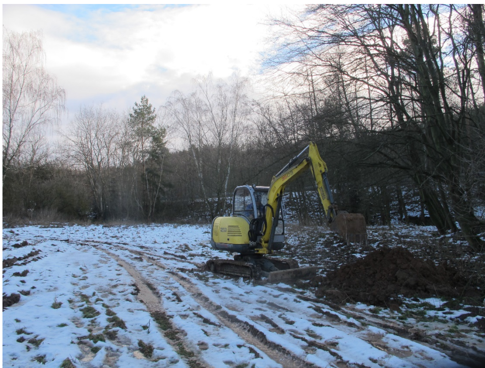
Obr. 3. Provádění kopané sondy KSH.
