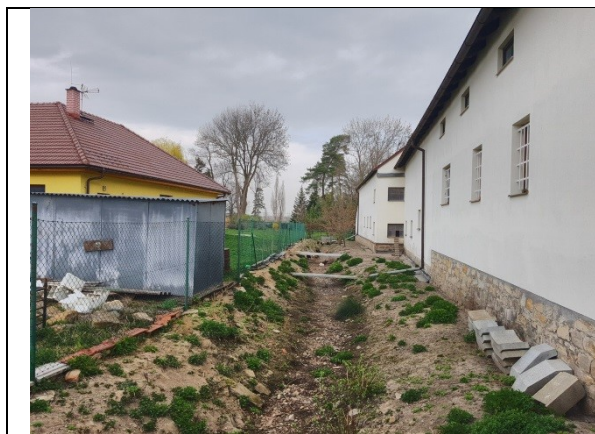
Otevřené koryto pod nádrží
