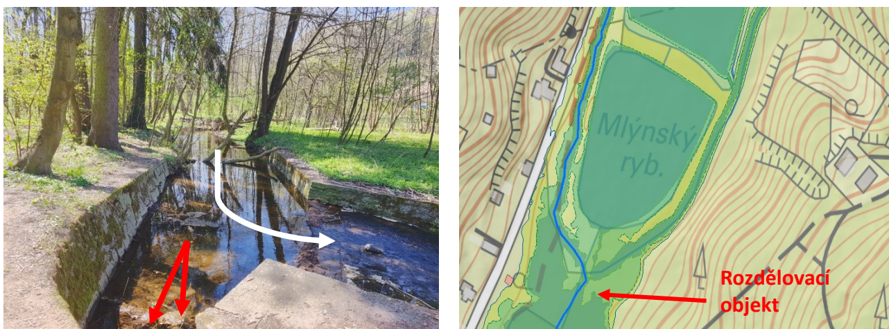
obr. 5-5: Rozdělovací objekt nad Mlýnskými rybníky
