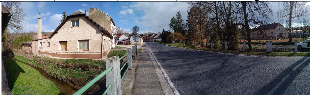
Intravilán obce Přistoupim, ohrožení zástavby z Jalového potoka
