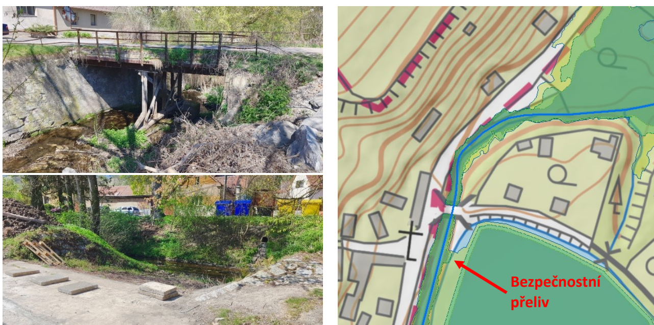
obr. 5-6: Bezpečnostní přeliv a mostní objekt Mlýnského rybníka
