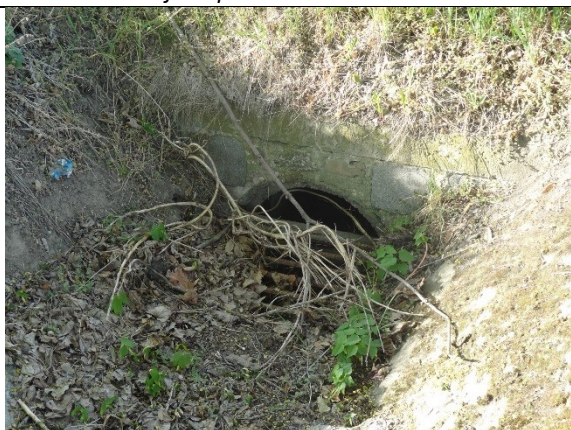
Zatrubnění v obci
