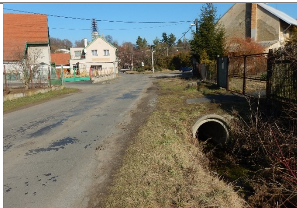
Nátok do zatrubnění Vitického potoka v obci Vitice
