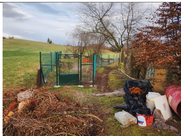
Severní část obce, pohled na vybudovaný odtokový kanál, KB ID 767174_01
