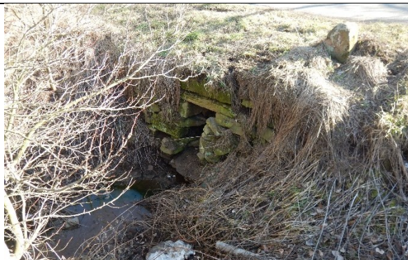
Nátok do propustku v obci Lipany
