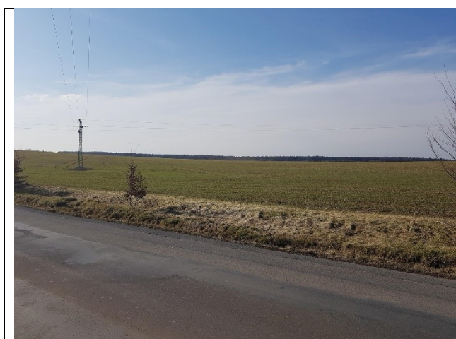
Severní část nad novou výstavbou, odvodňované pole „Pod Jabloní“
