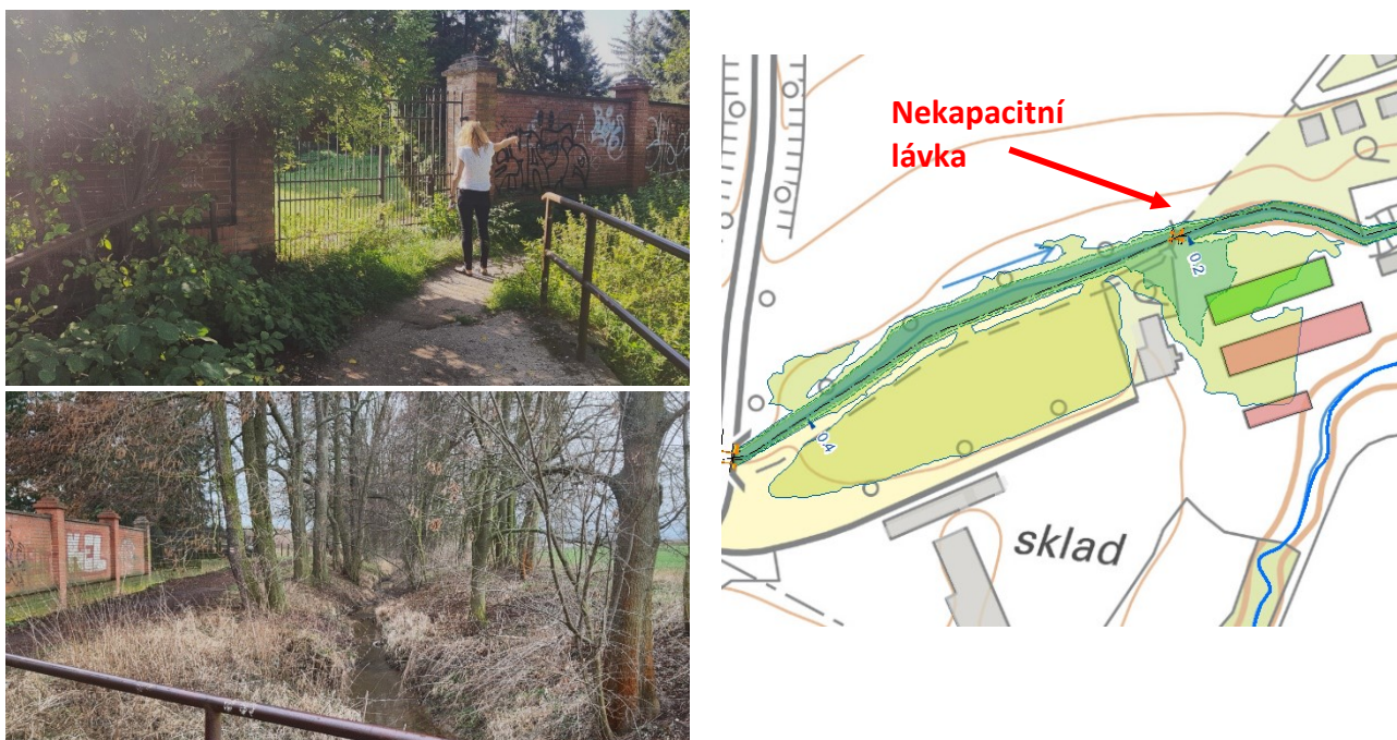
obr. 5-13: Nekapacitní lávka u zámku Chouranice
