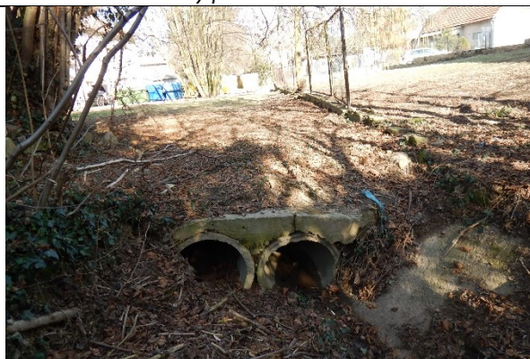
Nátok do zatrubnění levostranného přítoku Bylanky v Dobrém Poli
