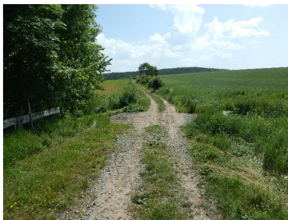
pohled na profil hráze od SV
