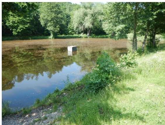
detail hráze, požerák
