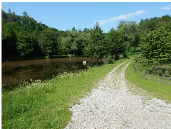
pohled na stávající hráz rybníka Pekárek od hlavní silnice
