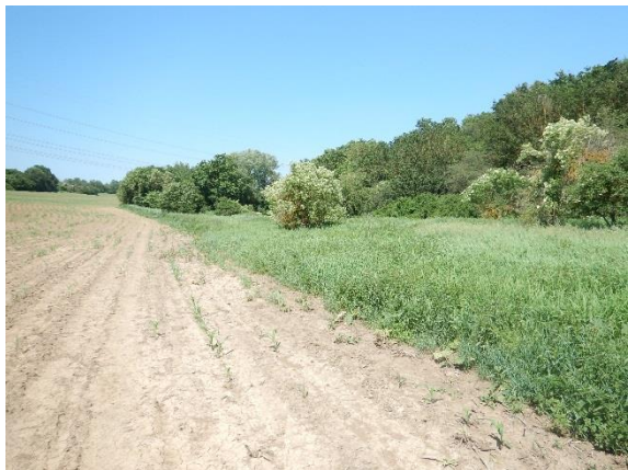
pohled na profil hráze proti směru toku
