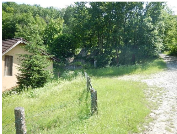
stávající objekt pod tělesem hráze
