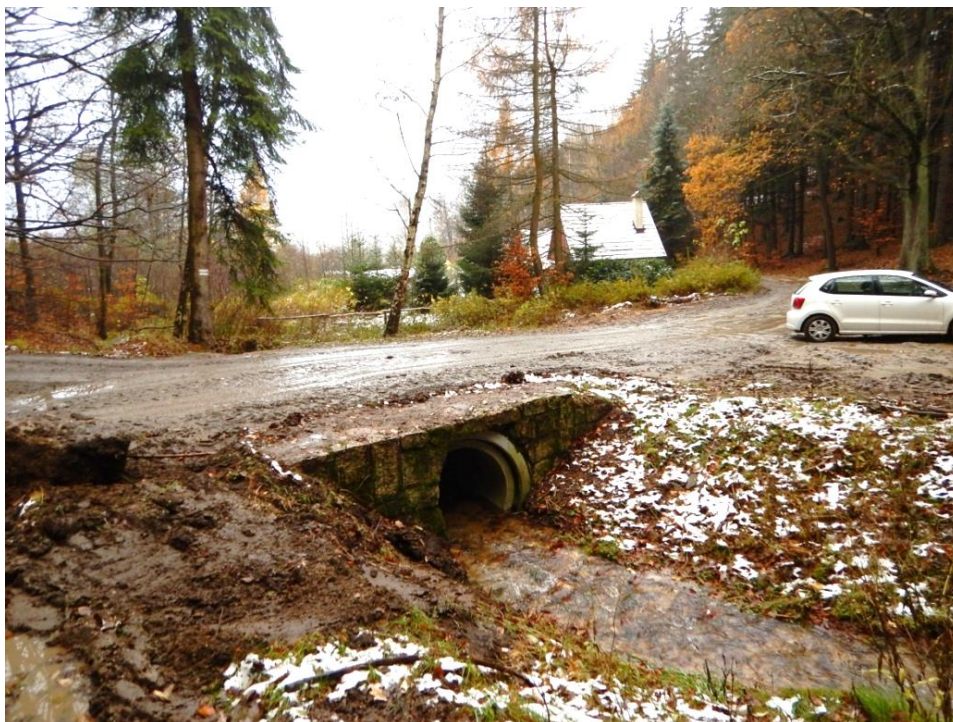
Obrázek 2: Propustek DN 1000 pod lesní cestou se nachází bezprostředně pod navrhovanou stavbou
