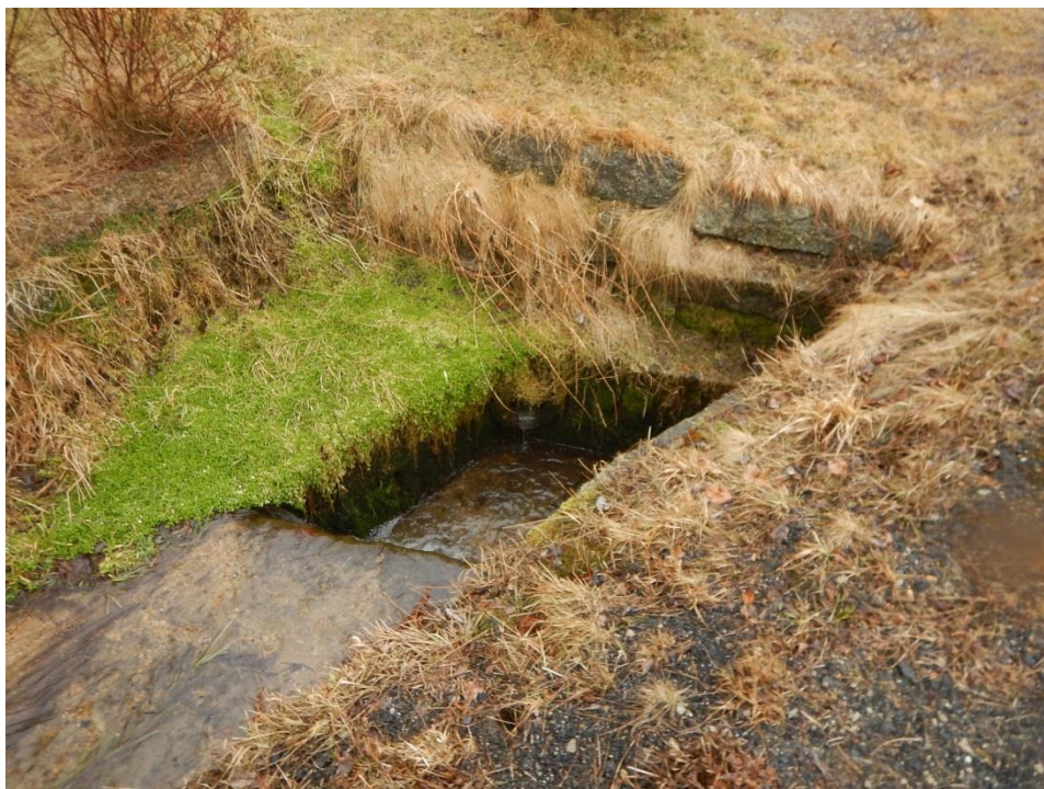
Obrázek 4: Příkop podél silnice je zakončen vpustí pro převedení přítoku Jeřice pod silnicí a dále zatrubněním pod soukromými pozemky
