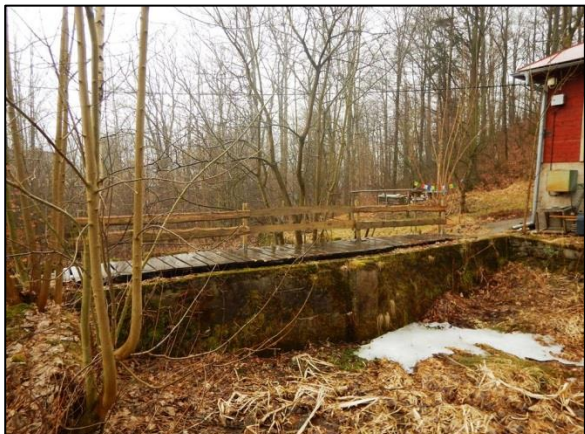
obr. 1 – poškozená zděná hráz horního rybníčku SO 05b
