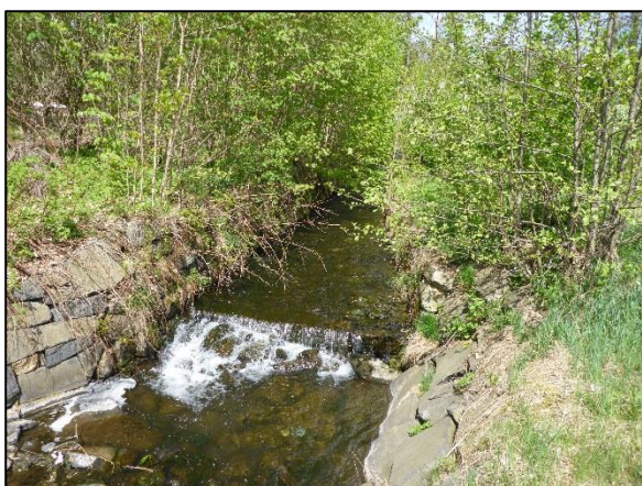
obr. 1 - Fotodokumentace upraveného úseku toku včetně vydlážděného dna koryta
