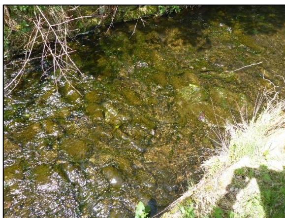
obr. 1 - Fotodokumentace upraveného úseku toku včetně vydlážděného dna koryta
