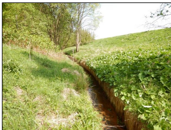
obr. 4 – odtok u vodního toku nad křížením se silnicí je urychlen svedením do betonového koryta s hloubkou cca 60 cm
