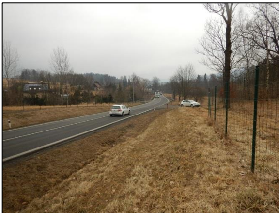
obr. 1 a 2 – systému odvodnění kolem kruhového objezdu nad Mníškem je sveden do málo kapacitního propustku a větší průtoky jsou přelévány přes silnici
