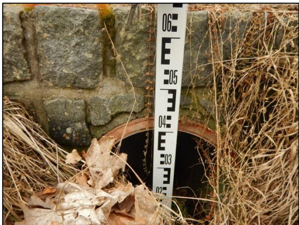
obr. 1 a 2 – systému odvodnění kolem kruhového objezdu nad Mníškem je sveden do málo kapacitního propustku a větší průtoky jsou přelévány přes silnici
