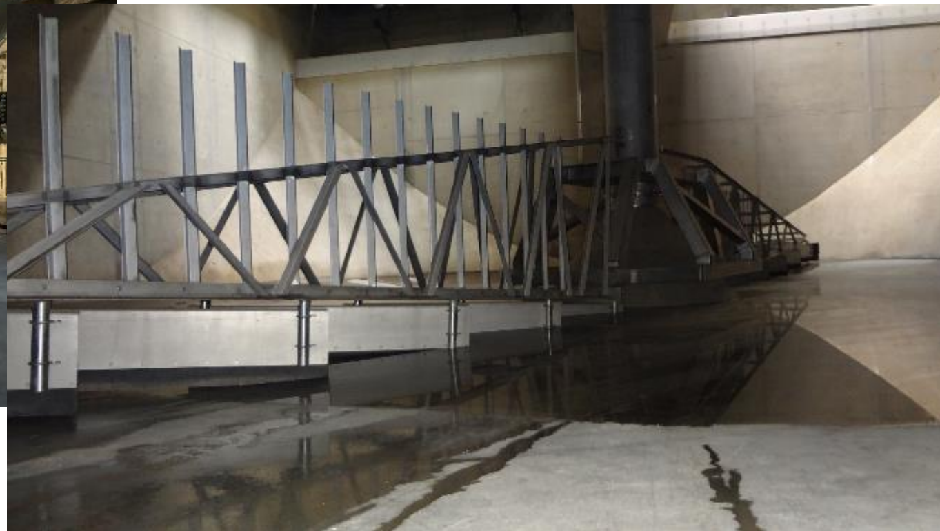
Usazovací nádrž Densadeg 4D
