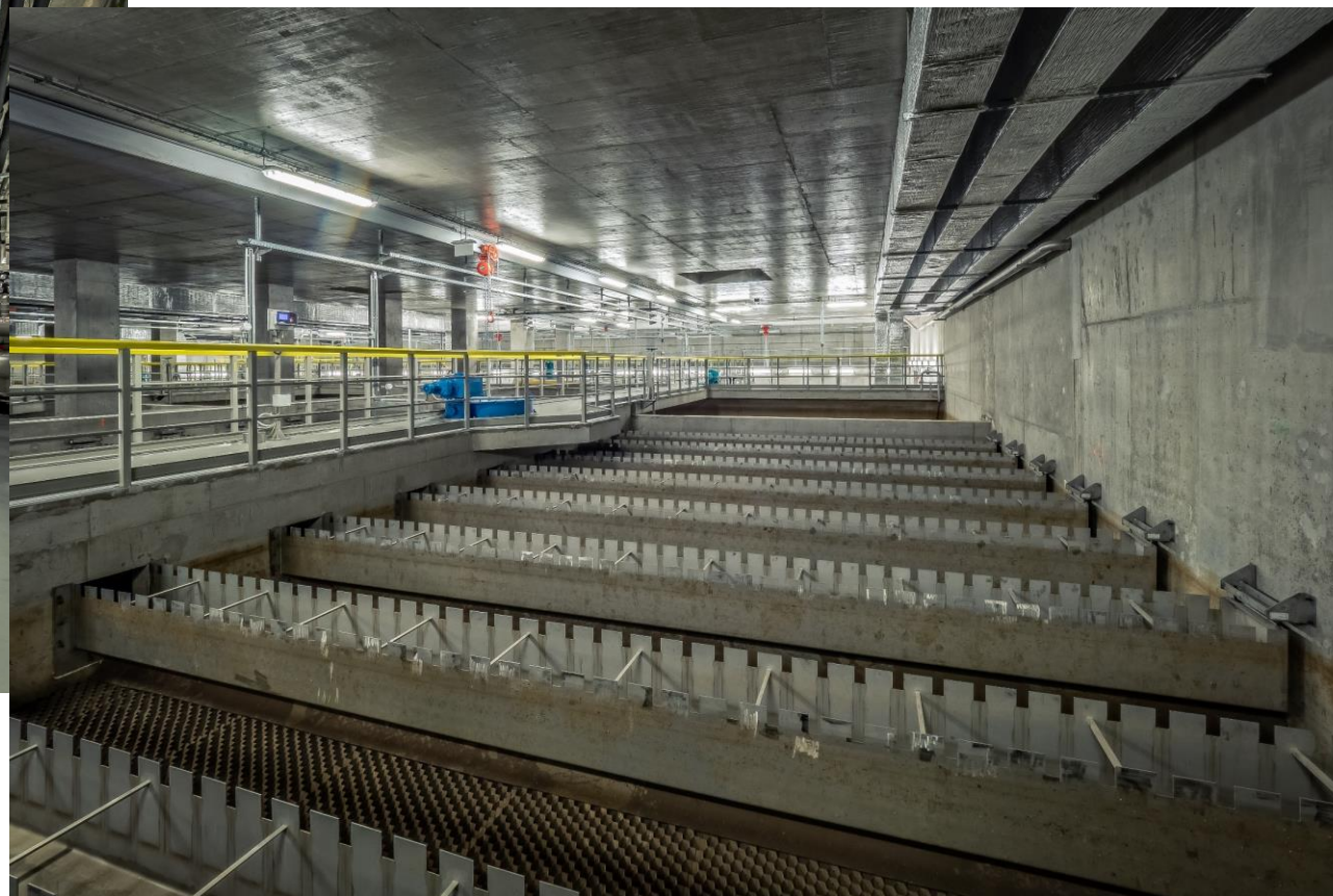
Usazovací nádrž na třetím stupni – Densadeg 2D
