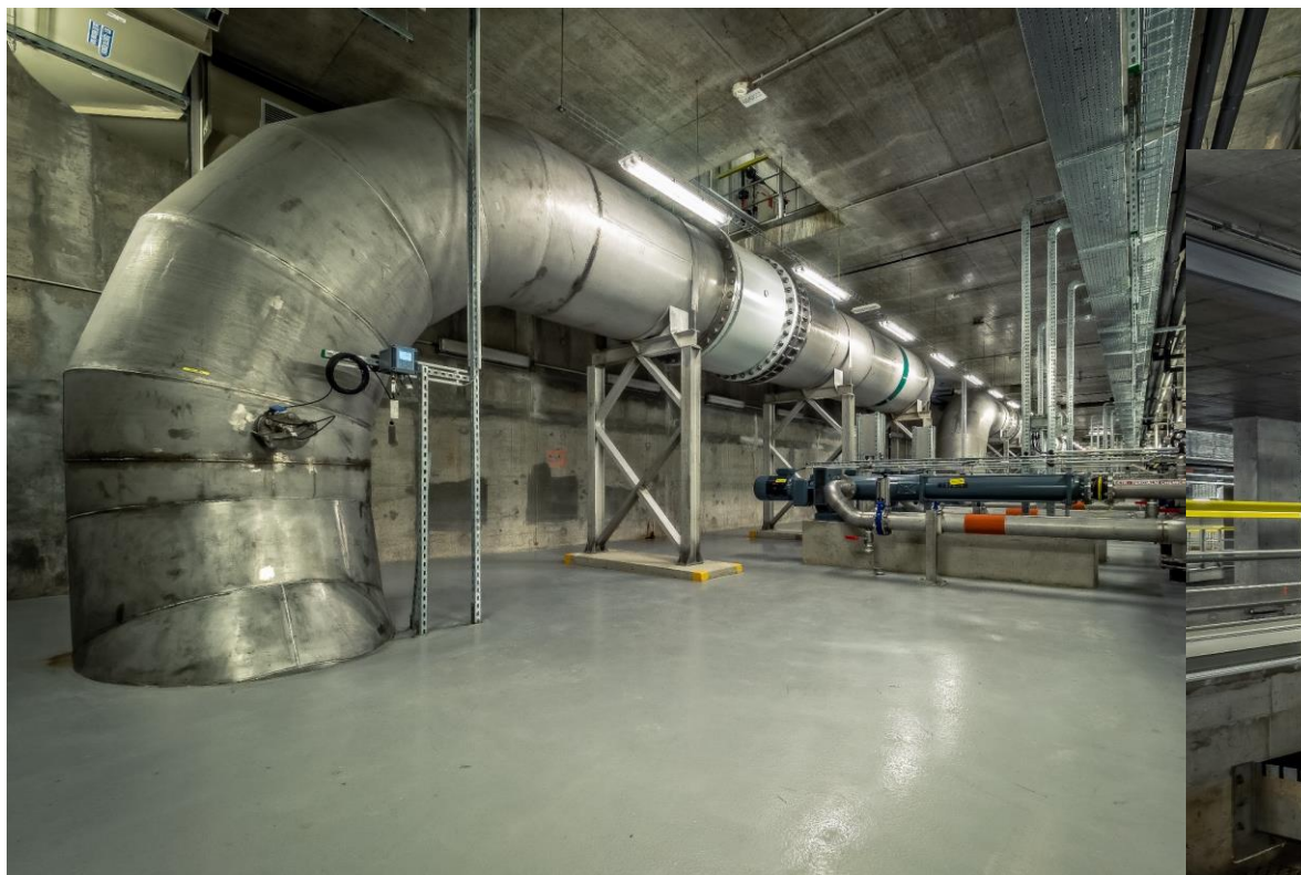
Nátokové potrubí do třetího stupně – DN 1400
