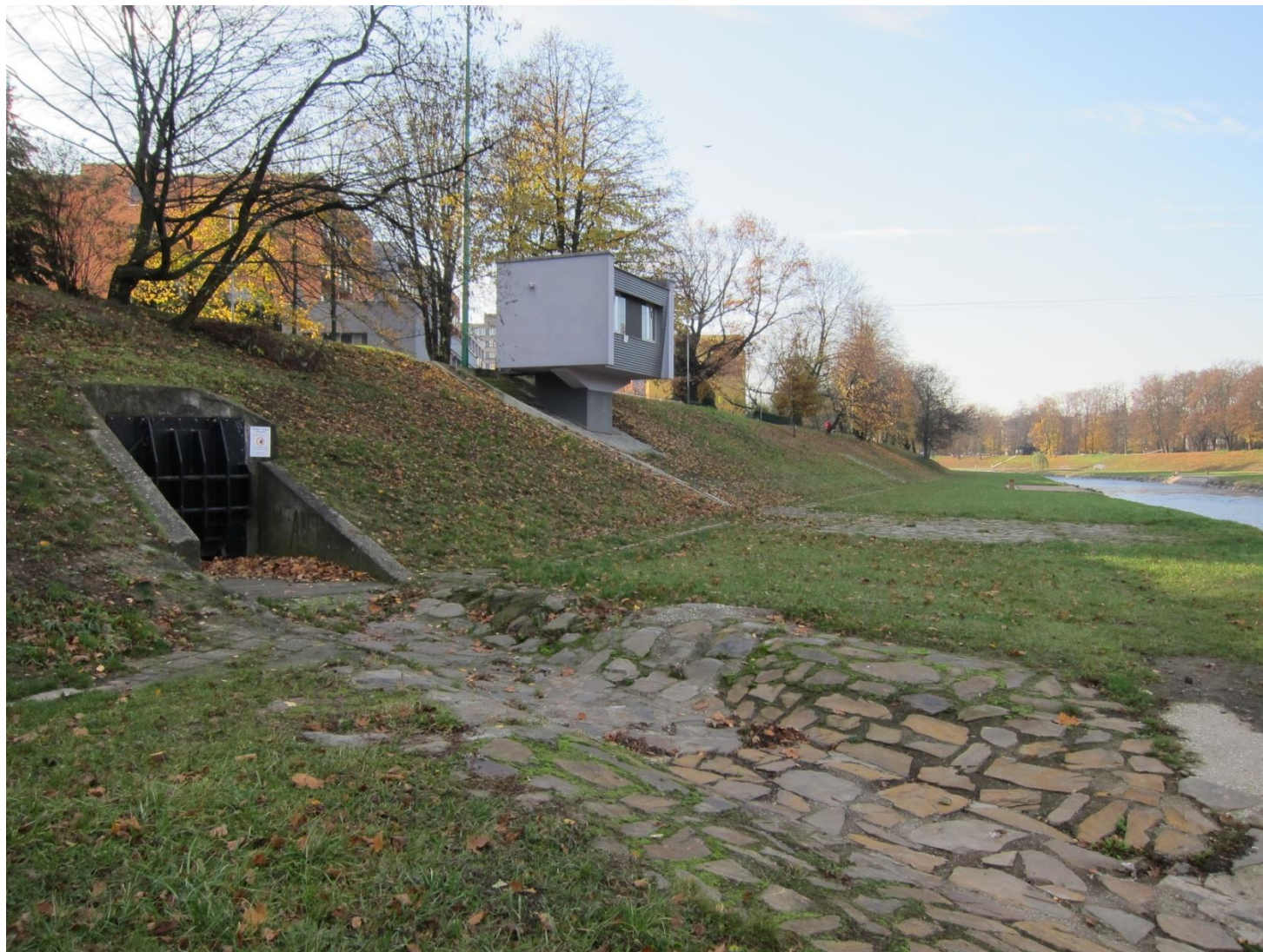
Ostravice, zpětná klapka na odlehčení jednotné kanalizace
